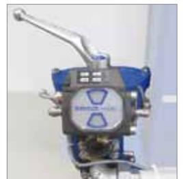
DOPPELFILTER UND DIFFERENZDRUCK-KONTAKT-ANZEIGE für Kühlwasser
