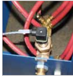
DURCHFLUSSWÄCHTER (Wasserkontrollschalter) im Wassereingang angeordnet
